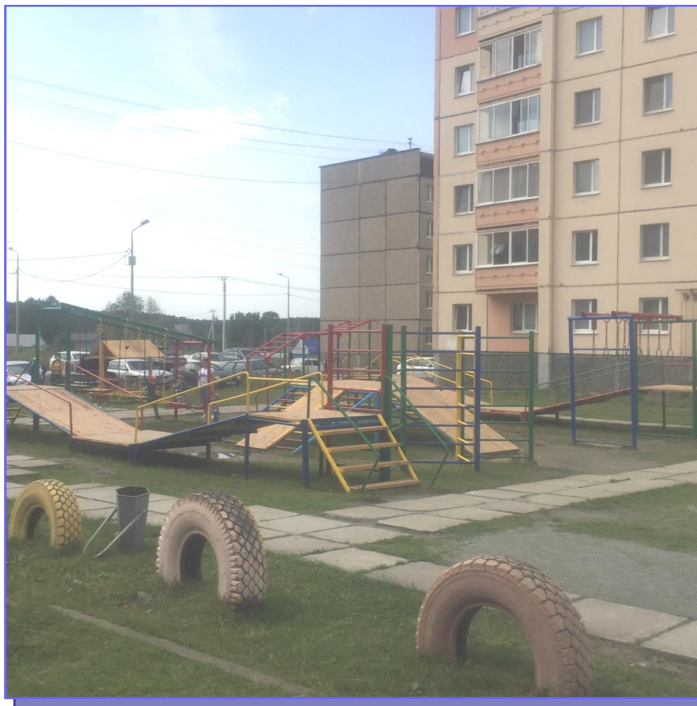
Двор на ул. Киевская после реконструкции
